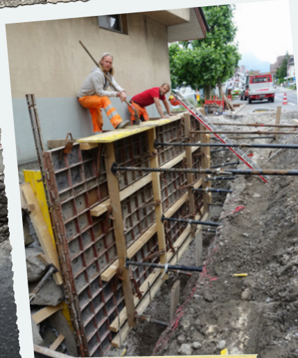
Theatergebäude Umfassende Aussenwandsanierung
