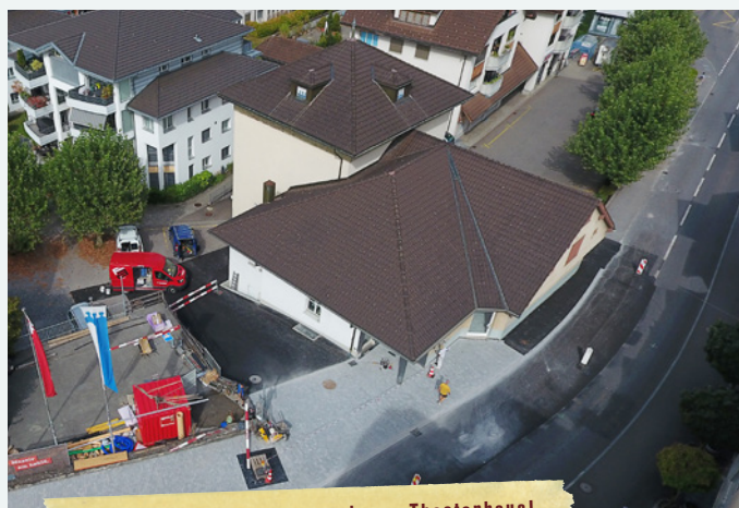
Neu gestaltete Umgebung rund ums Theaterhaus! Die letzten Umgebungsarbeiten werden ausgeführt. Auch die neuen Bäume werden in Kürze wieder gesetzt
